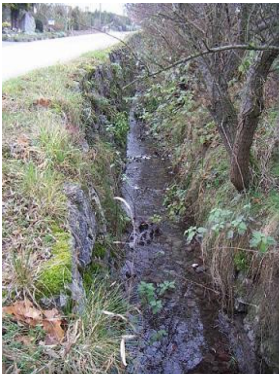
Verenamöslibach vor der Revitalisierung
