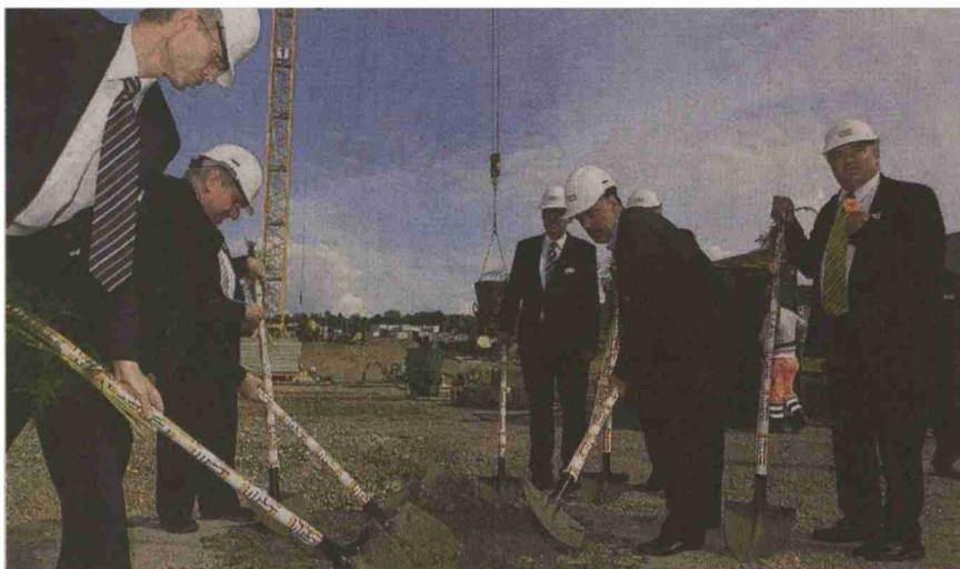
Mit vereinten Kräften wird der Grundstein gelegt.
