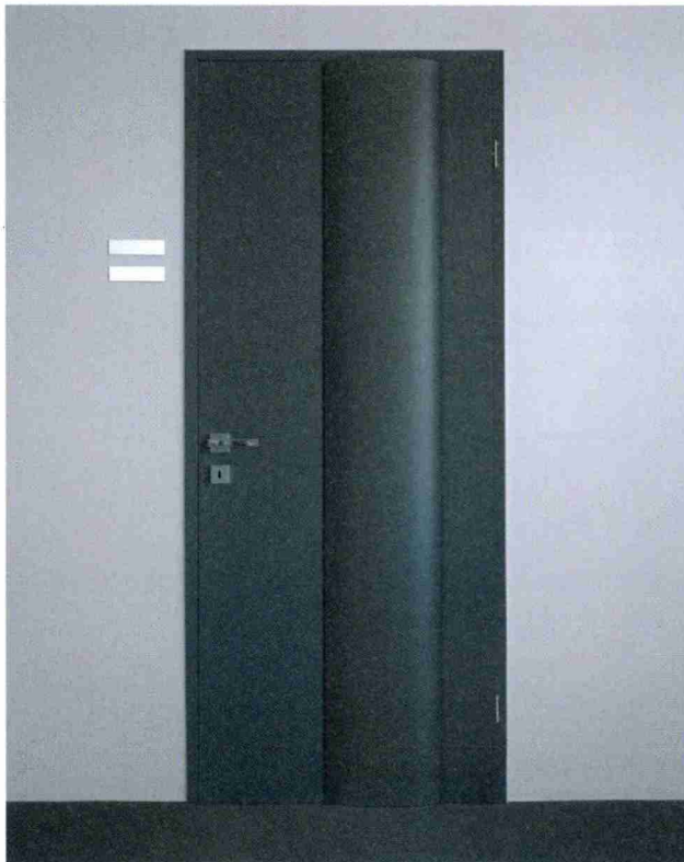
Die Materialisierung der Lüftungsabdeckung des Türlüfters ist flexibel. Somit lässt sich das Lüftungselement der Gestaltung des Innenraumes anpassen. (Quelle Erich Keller AG)
