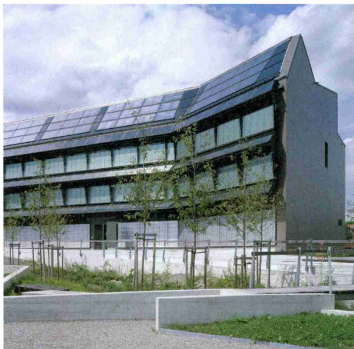
In Esslingen belüften 46 aktive Überströmer die Büros eines Geschäftshauses. Das von Basler und Hofmann geplante Gebäude wurde im Minergie-P-Eco-Standard gebaut und produziert seine Heiz- und Kühlenergie selbst. (Quelle Basler & Hofmann AG, Ingenieure Planer & Berater)
