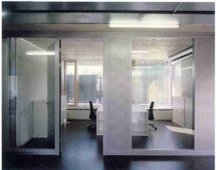
Neben den Bürotüren in Zwischenwände integriert, sorgen die Lüftungselemente der Erich Keller AG für frische Büroluft. (Quelle Basler & Hofmann AG, Ingenieure Planer & Berater)
