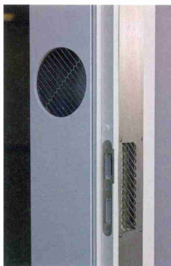
Wie bei der Türlüftung bietet der Überströmer im Türrahmen einen bedarfsgerechten Betrieb. Der Lüfter läuft nur, wenn es nötig ist – bei geschlossener Tür. (Bild: FHNW)
