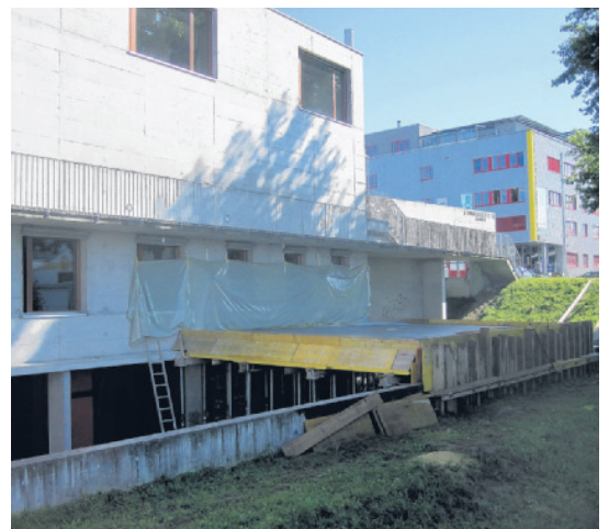
Die Aussenansicht des Kulturwerks, mit dem Betondeckel im Rohbau
