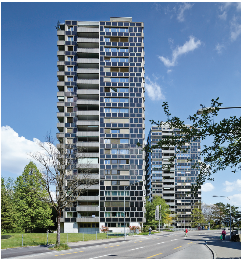
FHNW-Forscherin Dr. Monika Hall hat ihre Simulation unter anderem an diesem Mehrfamilienhaus an der Sihlweidstrasse in Zürich validiert, das von Harder Haas Architekten saniert wurde.
