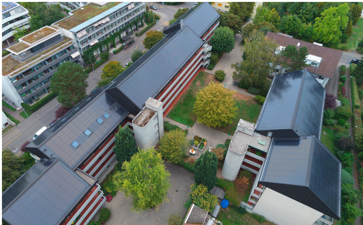
Die Photovoltaik-Anlage auf zwei Dächern der Riehener Alterssiedlung Drei Brunnen hat eine Peak-Leistung von 265 kW und produziert im Jahr rund 220 000 kWh Strom.
