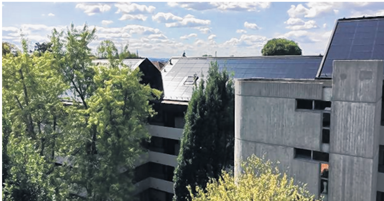
Oberdorfstrasse 3, das Gebäude der Alterssiedlung «Drei Brunnen».
