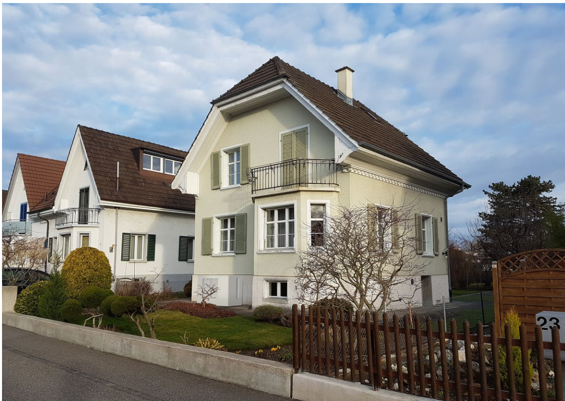
Abbildung 73: Kleine Luft/Wasser-Wärmepumpe farblich der Gebäudefassade angepasst.
