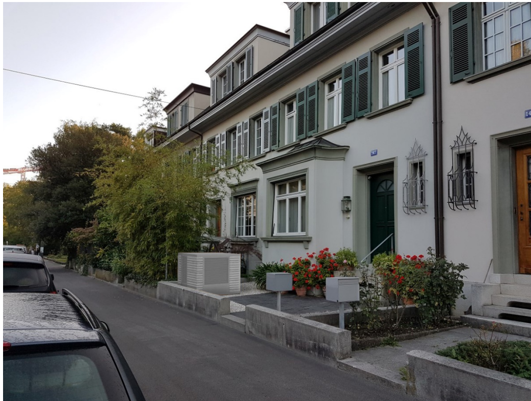
Abbildung 74: Sichtbare Aufstellung in beengter Vorgartensituation.
