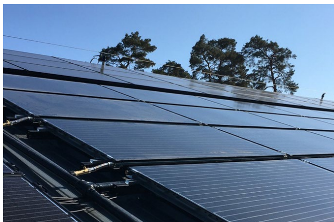
Abbildung 62: Dach-PV-Thermie-Kollektor als Wärmequelle einer Luft/Wasser-Wärmepumpe. Quelle: Consolar
