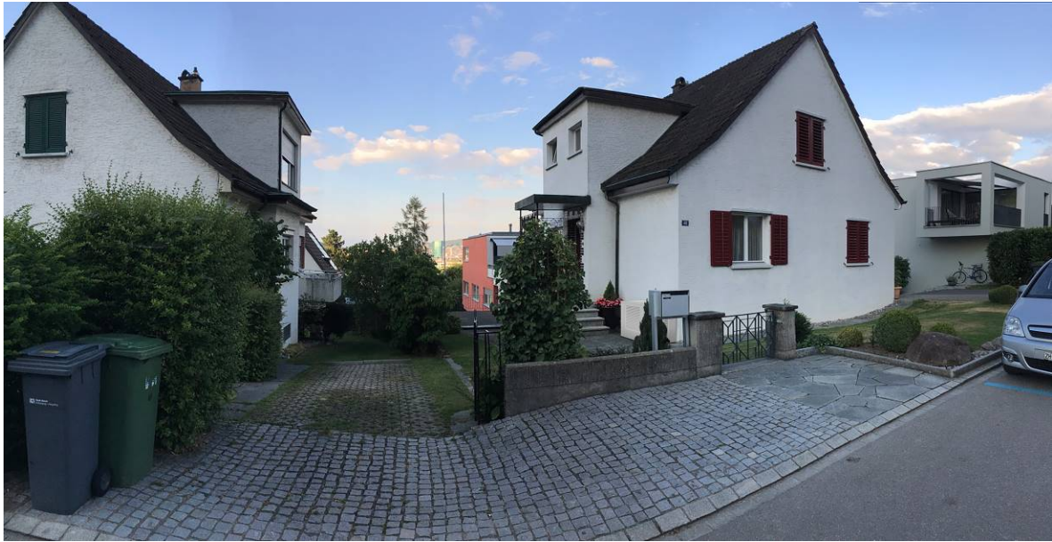
Abbildung 72: Kleines Gerät integriert an Gebäudefassade (hinter Briefkasten).
