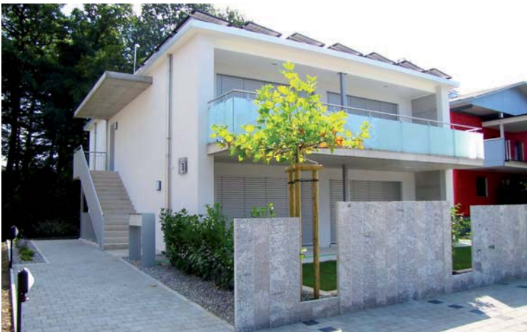
Das «Plusenergiehaus mit Elektromobilität» in Rapperswil: Minergie-P-Eco, auf dem Dach die PV-Anlage mit total 20 kWp Leistung. (Foto: Setz Architektur)
