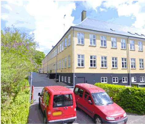
DK10_Egeskolen Building Nr. 1, Jonstrupvangvej 150 D, 3500 Værløse
