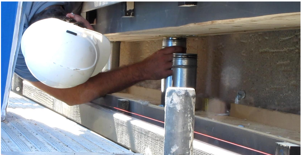
Abbildung 55: Zusammenfügen von Fassadenmodulen am Bau, inkl. Vorgang Verbindung von Lüftungsleitungen
