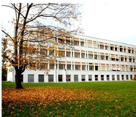
CH01_Schulanlage Spiegelfeld Nr. 7, Im Kugelfang 7, 4102 Binningen
