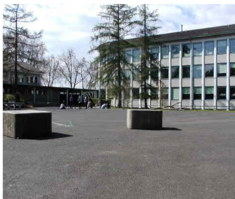
CH08_Hirzbrunnenschulhaus , Zu den drei Linden 80, 4058 Basel
