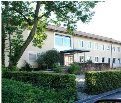
CH04_Schulanlage Gründen Nr. 47, Gründenstrasse 47b, 4132 MuttENZ
