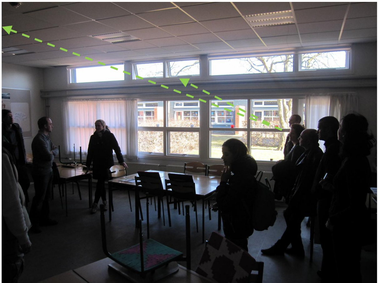
Abbildung 65: Kindergarten Værløse, DK – Frischluftzufuhr mit automatischer Fensterlüftung und unterstützendem Abluftventilator (siehe Pfeile im Bild)
