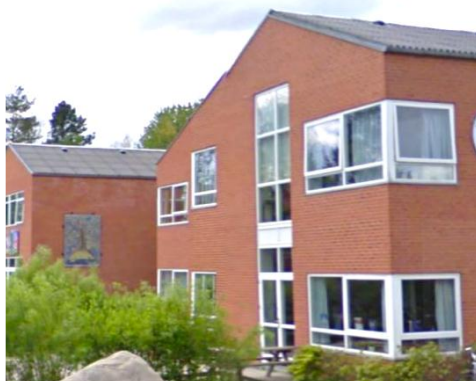
DK05_Kongevejens skole Building Nr. 1, Kongsvænget 10, 2830 Virum1
