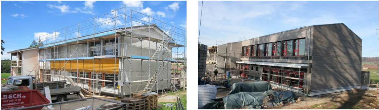
Abbildung 70: Ansicht des Schul-/Wohngebäudes zu Beginn der Erneuerung und kurz vor Fertigstellung
