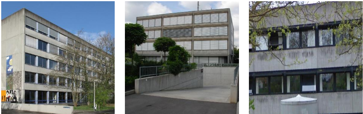
Abbildung 44: Bandfassaden bei den Fallbeispielen CH05 (links – CCTP), CH07 (mittig – CCTP) und DK02 (rechts – DTU)
