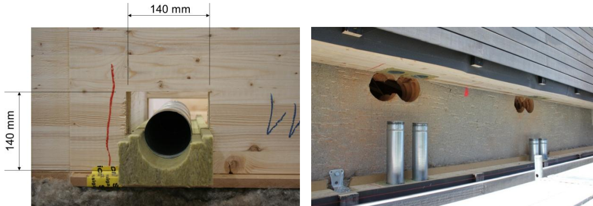
Abbildung 72: links: Detail eines Lüftungsrohres bei der Montage der Module im Werk, rechts: Zusammenführen zweier Module mit Lüftungsrohren bei der Montage am Gebäude
