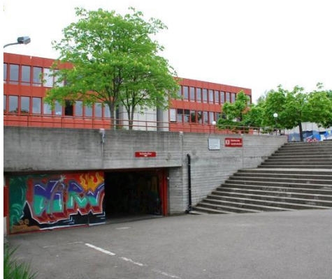
CH06_Schulanlage Känelmatt II Nr. 11, Känelmattweg 11, 4106 Therwil
