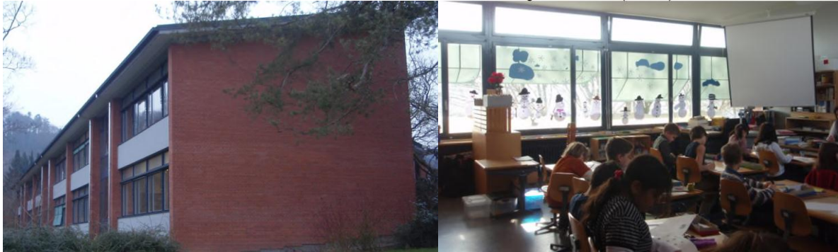
Abbildung 64: Schulhaus Untermoos in Zürich, CH – Frischluftzufuhr mit automatischer Fensterlüftung (links: Südost-Ansicht, rechts: automatisch geöffnete Fenster während dem Unterricht)
