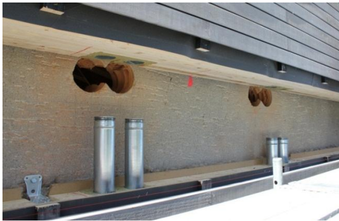
Abbildung 42: Aufteilung des erforderlichen Lüftungsquerschnittes in opaken Bereichen.
