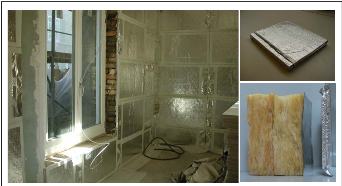
Abb. 2: Vakuum-Isolations-Panel (VIP), hier eingesetzt als Innendämmung bei einer Altbausanierung der Architekten Viriden und Partner in Zürich.
