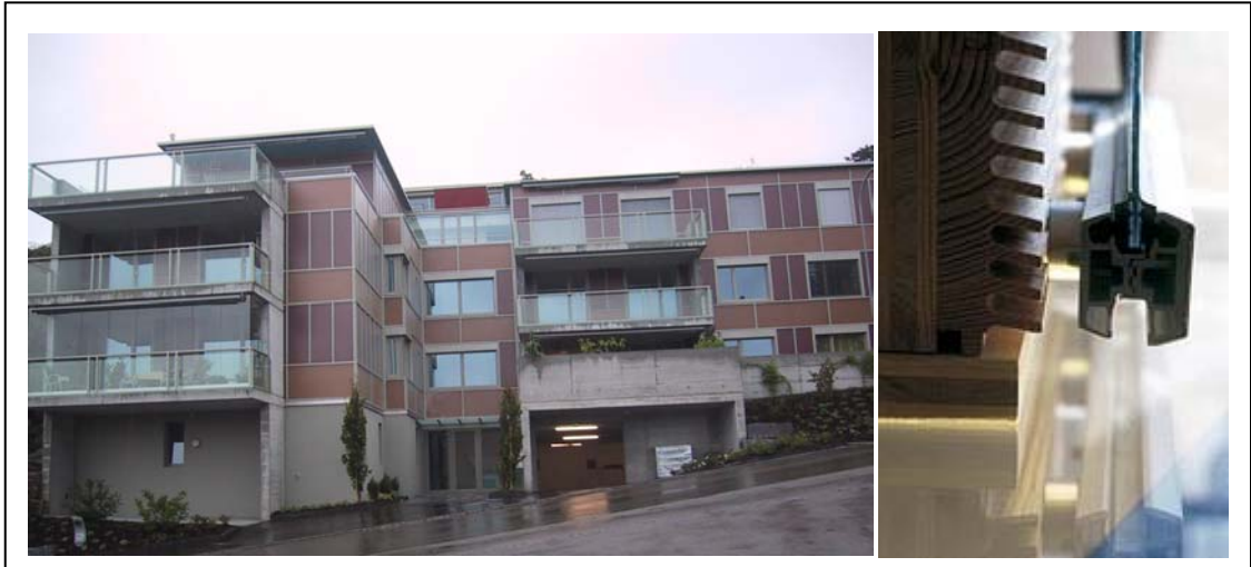
Abb. 12: Solarfassade vom Typ LUCIDO, eingesetzt an einem Mehrfamilienhaus in Wil SG.
