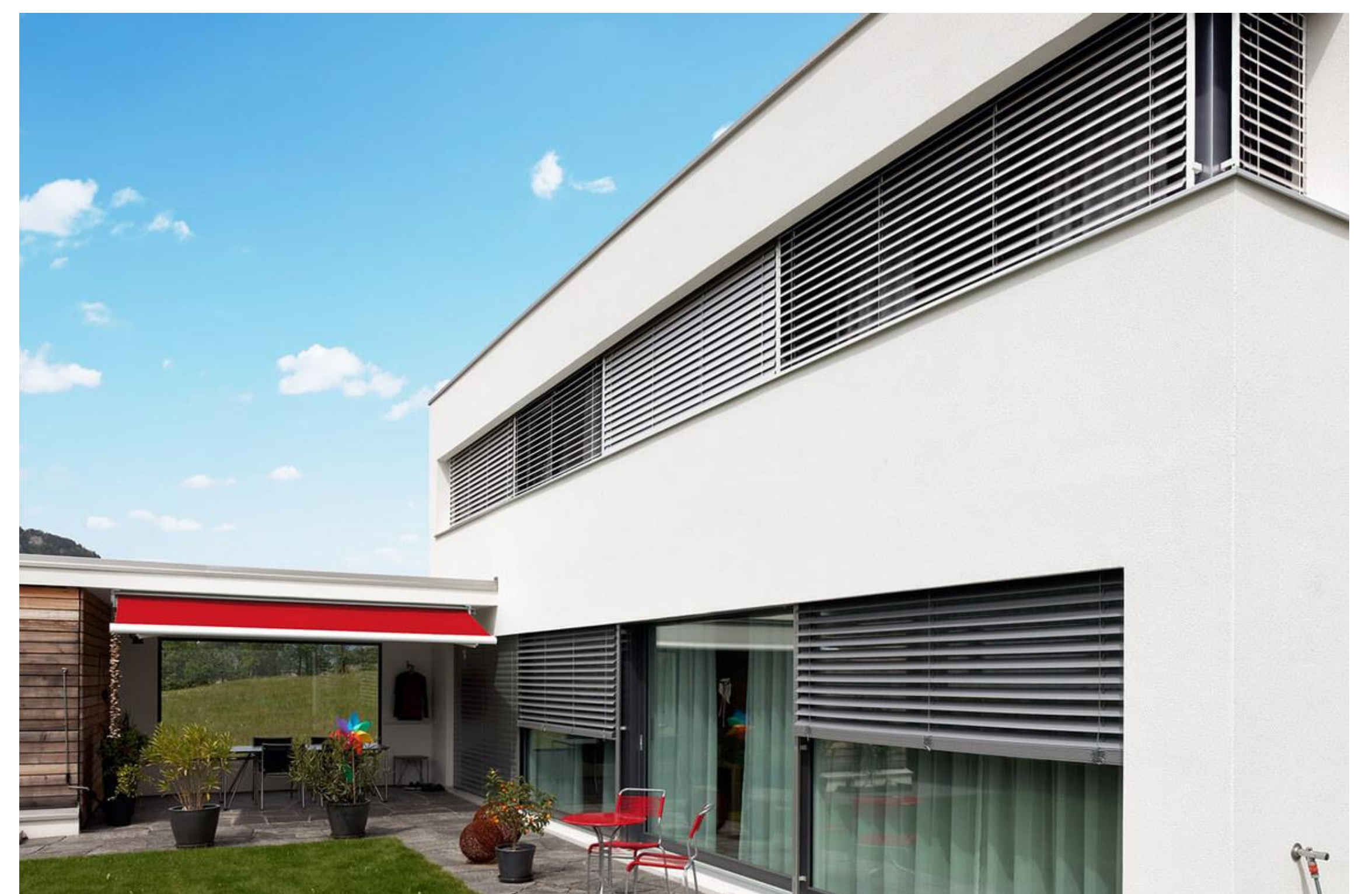
Abb. 3: Fassade mit Lamellenstoren (Quelle: Schenker Storen AG, www.storen.ch)
