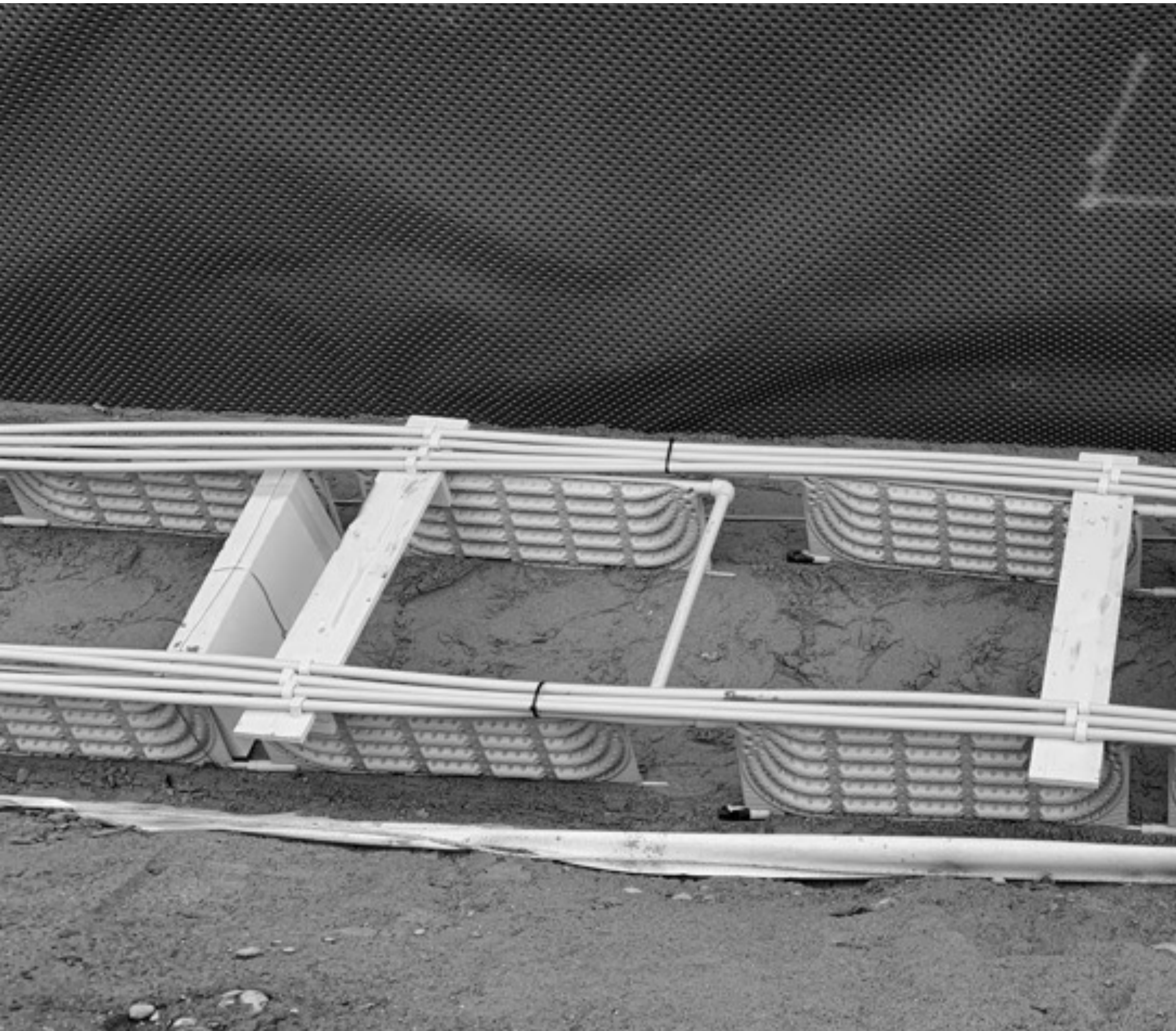
Abb. 1: Verbaute Erdreichabsorber, welche dem Erdreich die Energie zur Beheizung des Gebäudes entziehen.
