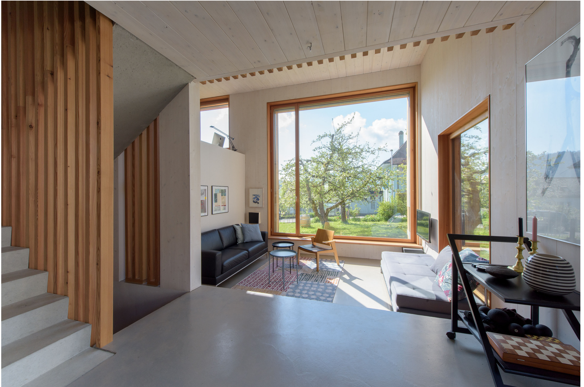
Doppel-Wohnhaus Rosenweg in Köniz; Solares Direktgewinnhaus _ genügend Speichermasse und sommerlich Wärmeschutz der Verglasungen, Böden über UG Beton, ohne Umterlagsböden
