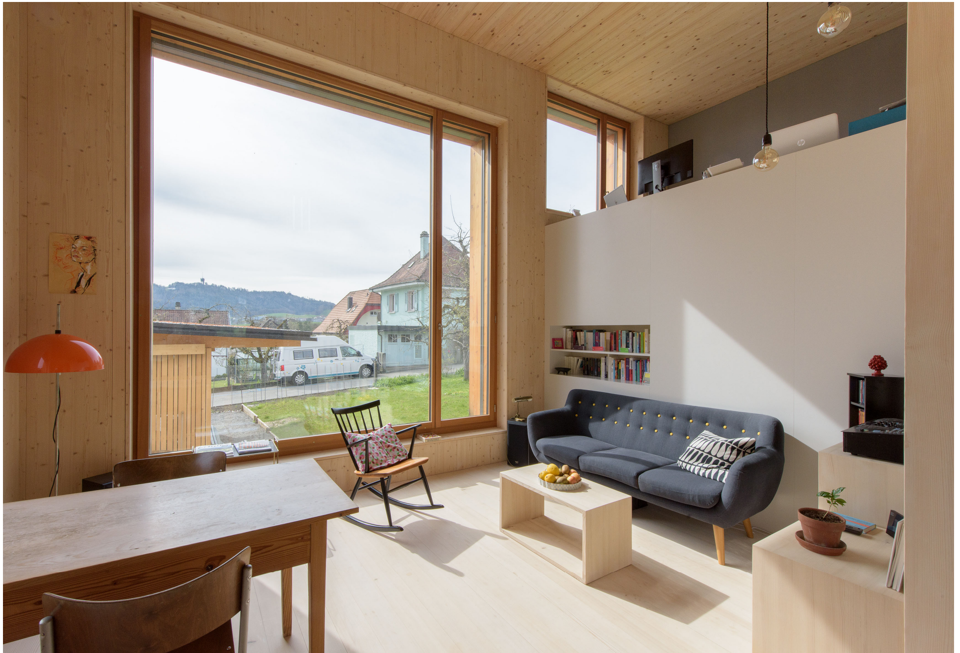
Doppel-Wohnhaus Rosenweg in Köniz; Solares Direktgewinnhaus _ Holzbauweise, Gebäudehülle Minergie-P, eine Komfortlüftung, keine Heizungsverteilung, dachflächenintegrierte PV-Anlage
