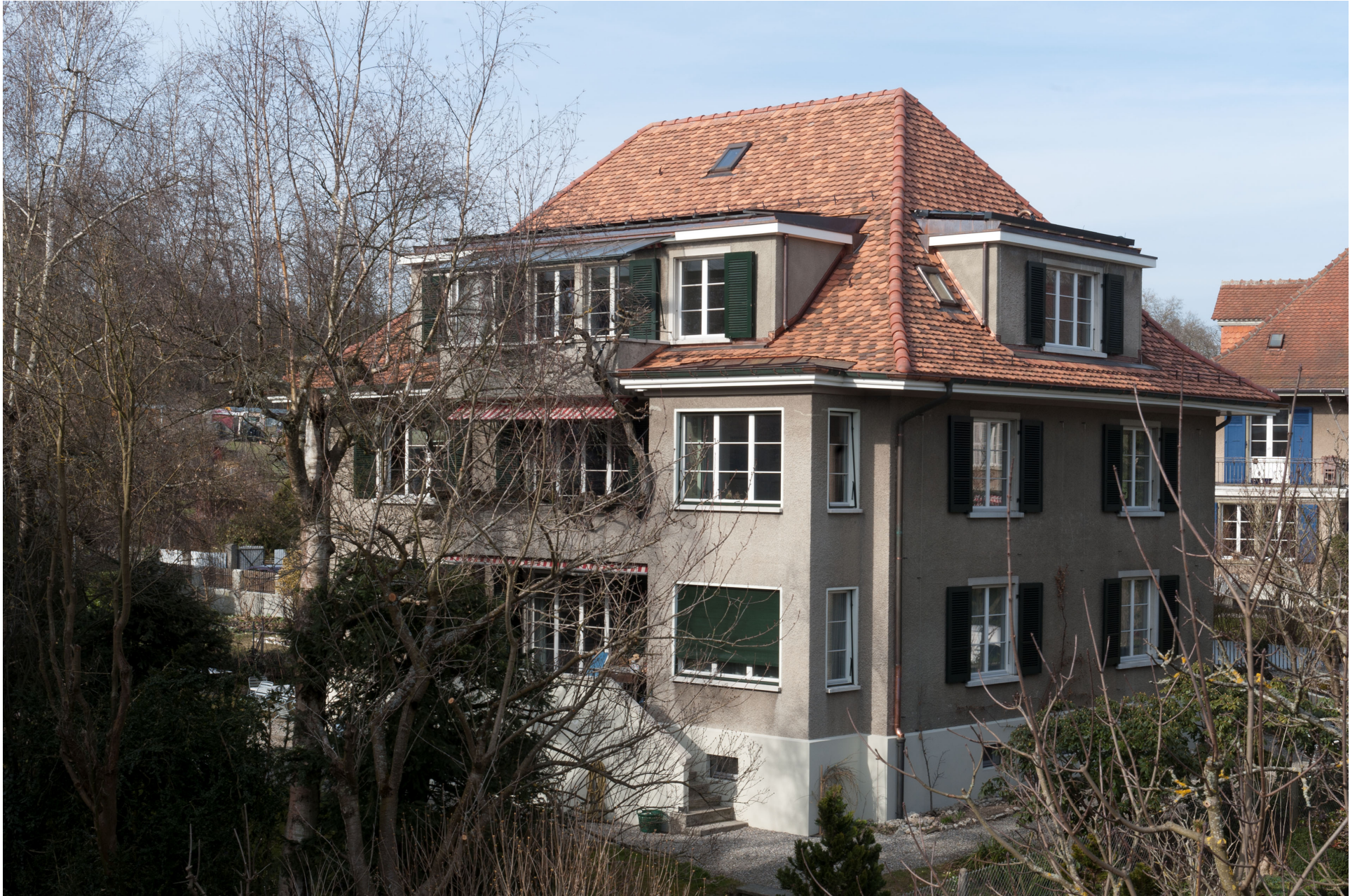
PV-Anlage auf Lukarnendächern
