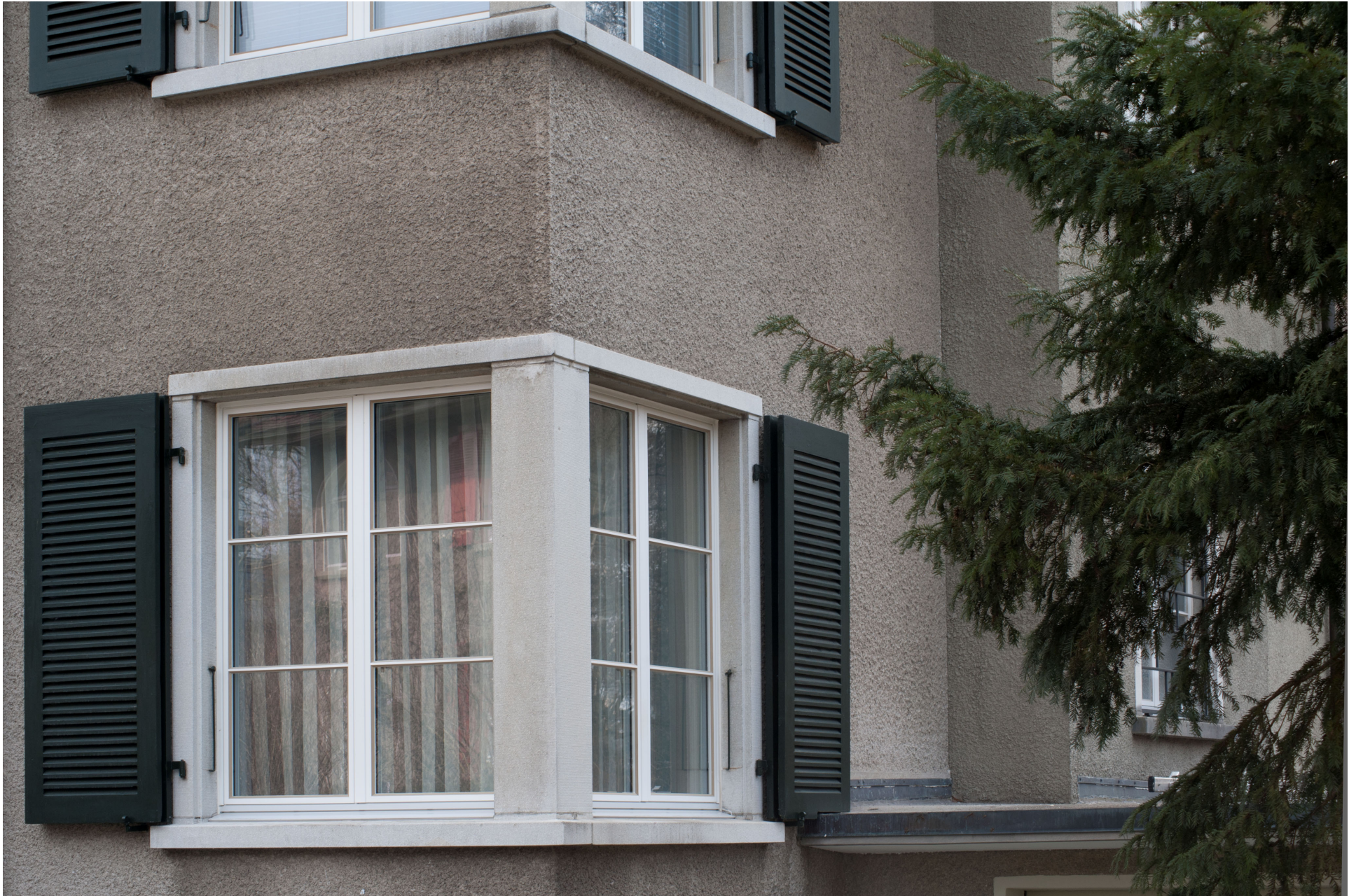
Partielle Fassadendämmung mit Dämmputz
