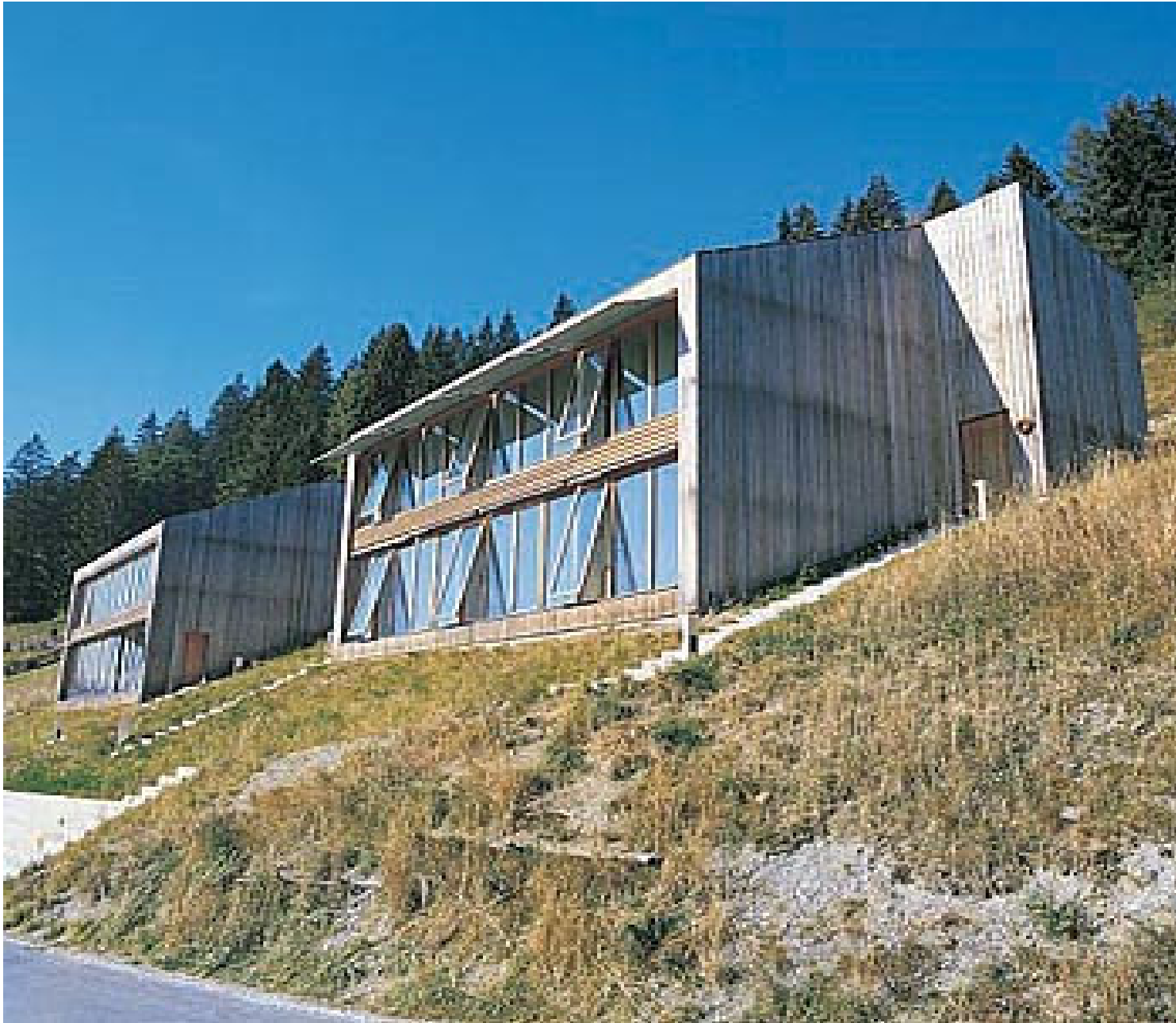
Energieautarke „solare Direktgewinnhäuser“ in Trin, Baujahr 1994; Architekt Andrea Ruedi
