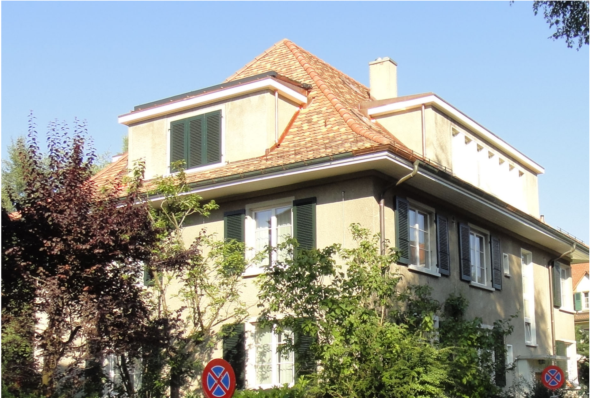
Fensterersatz denkmalgeschützte Ausführung, Dachdämmung, Röhrenkollektoren
