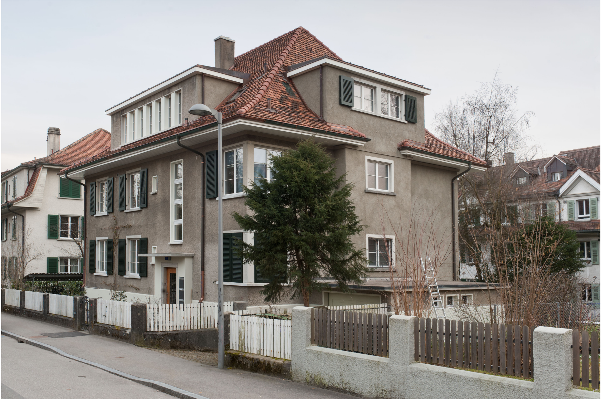
_nach der Sanierung
