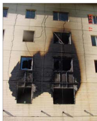
60. Prüfminute Schädigung ohne Löschen
