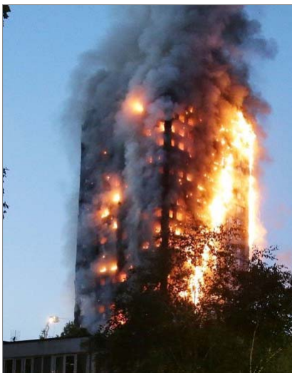
London, Brand in Hochhaus; 79 Tote 14. Juni 2017
