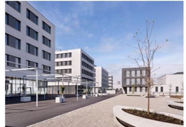
Verwaltungszentrum Neumatt, Burgdorf
