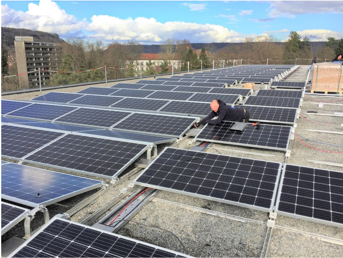
Fig. 10: Montage der Photovoltaikmodule, 17.03.2018
