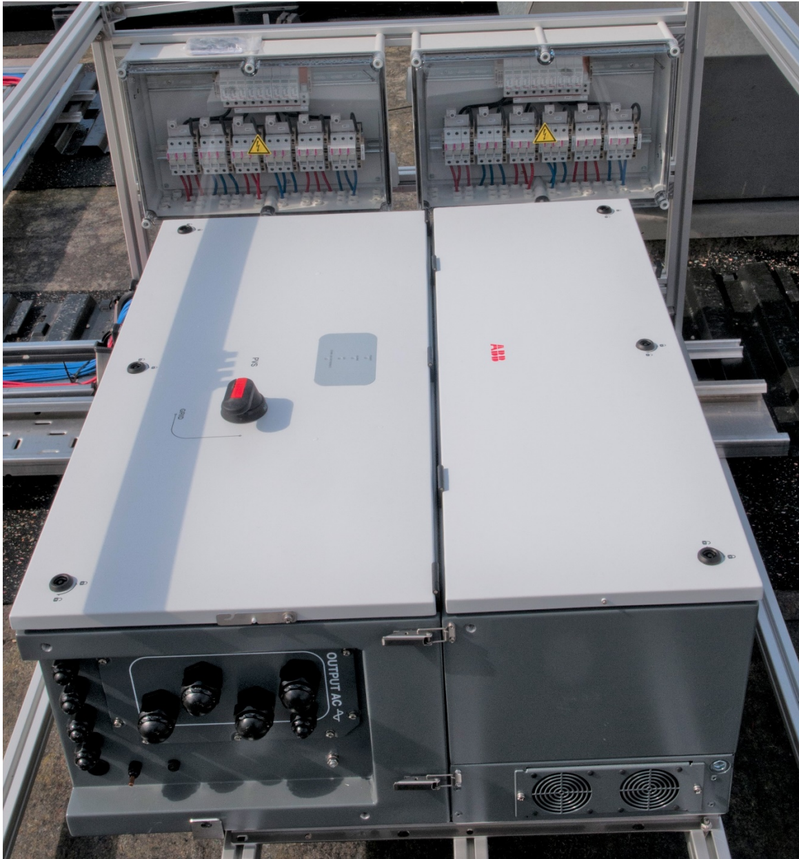
Fig. 12: Installation der ABB-Wechselrichter, 23.03.2018
