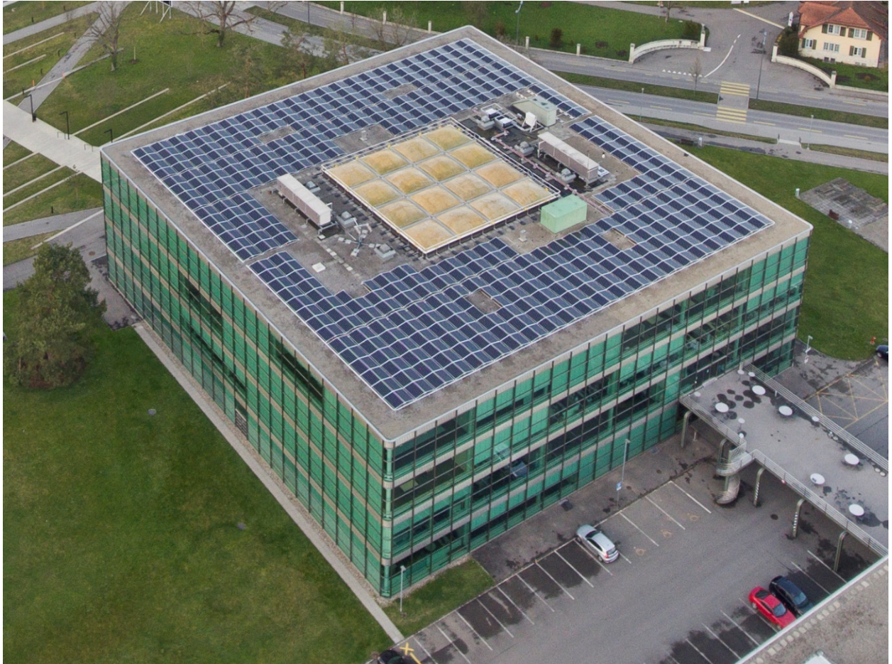
Fig. 5: Das 230 kW p -Photovoltaik-Kraftwerk auf dem Hallerbau (Foto: Sandro Roth irixdesign.ch)
