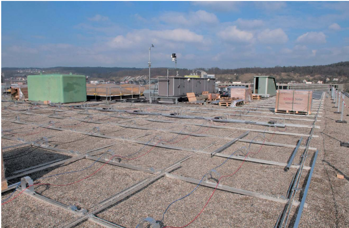
Fig. 8: Abgeschlossene Vorbereitung der Tragkonstruktion für die Montage der 756 Photovoltaikmodule, 14.03.2018
