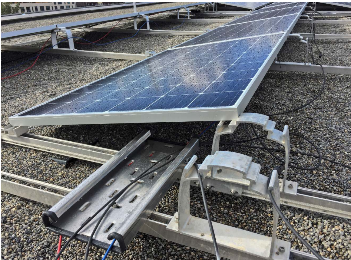
Fig. 9: Montage der Photovoltaikmodule des Typs Longi LR6-30PE-305M, 16.03.2018
