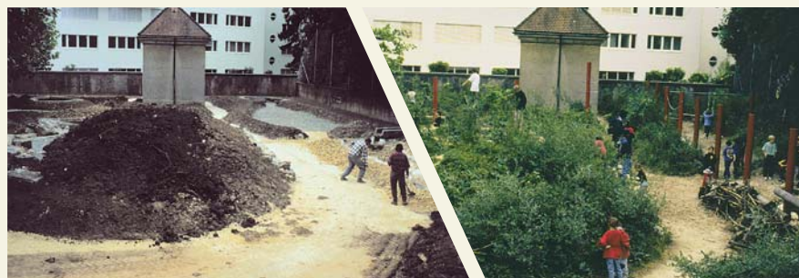
Spielanlage im Schulhaus – im Bau 1996 (Solothurn, Schweiz)
