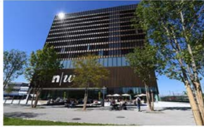
Hochschule für Architektur, Bau und Geomatik
