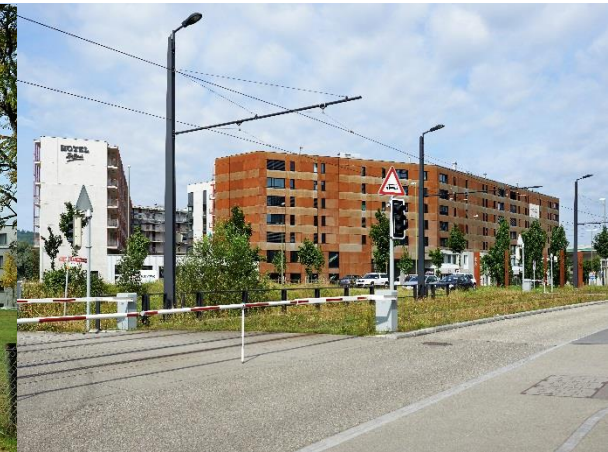
Die Siedlung Zwicky Süd in Dübendorf, Zürich Nord – auf dem Areal der ehemaligen Spinnerei Zwicky im Grenzbereich von Zürich, Wallisellen und Dübendorf
