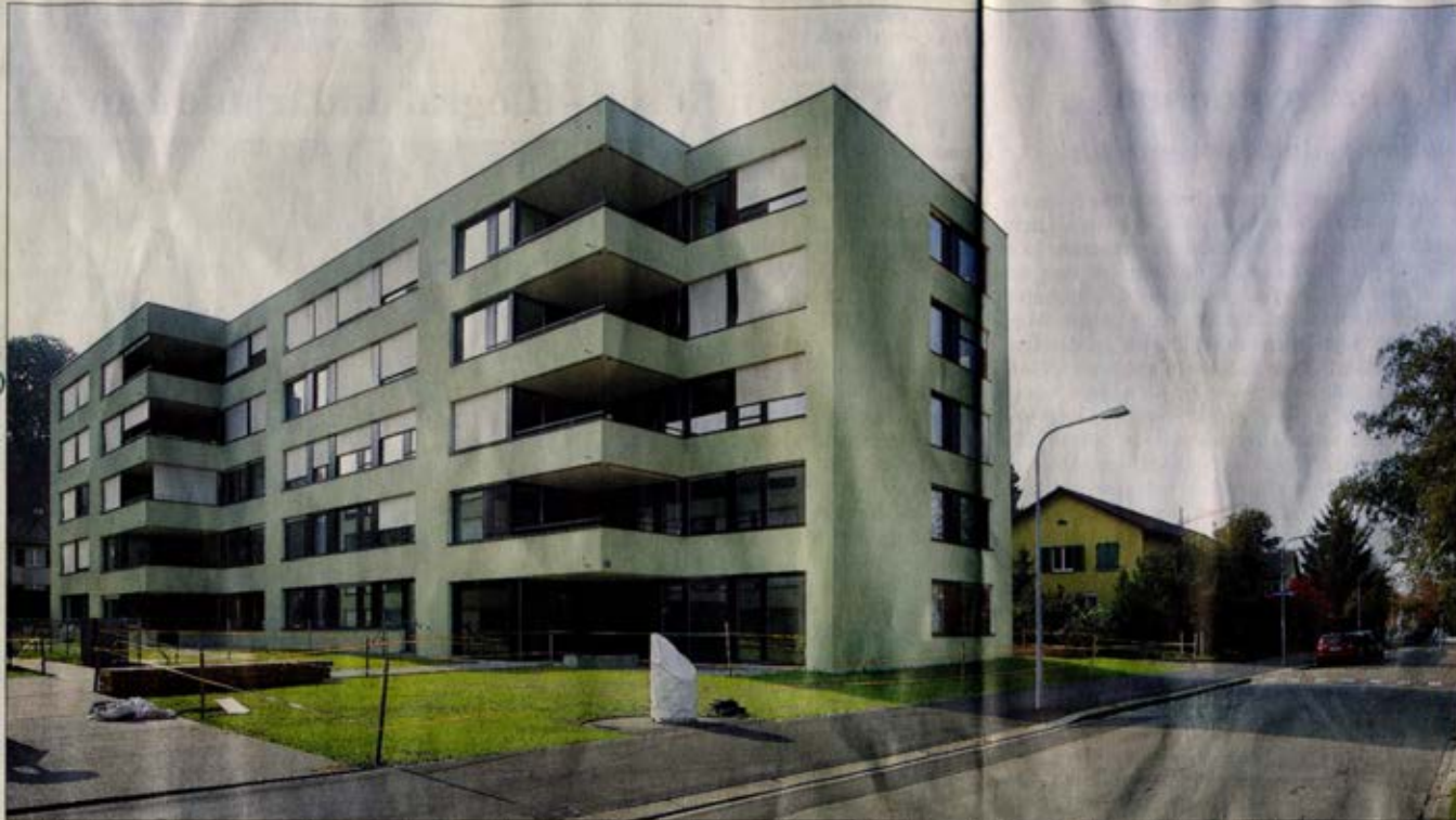
Die Neubauten stehen quer zur Katzenbachstrasse und verbinden die beiden benachbarten Grünräume der Freizeitanlage und des Buhnhügels. CHRISTIAN BEUTLER
