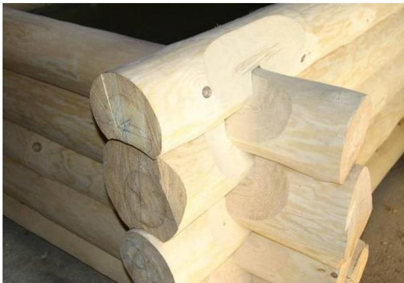
Abb. 12: Blockhausbau mit Enkelkattsknut
