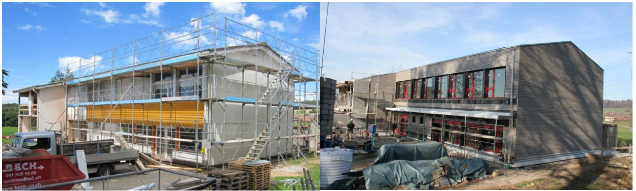
Abbildung 6 Ansicht des Schulhauses Krumbach zu Beginn der Erneuerung (links) kurz vor Fertigstellung (rechts)
