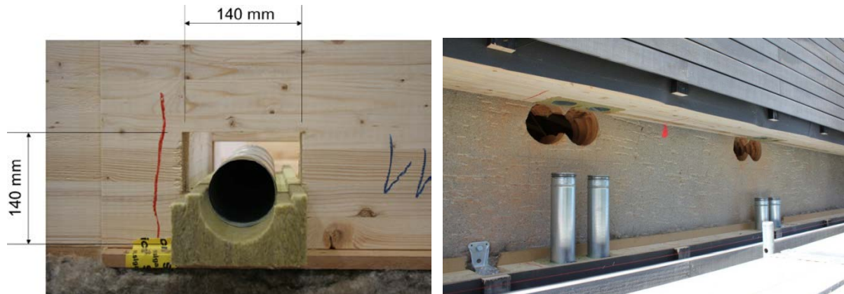
Abbildung 8 links: Detail eines Lüftungsrohres bei der Montage der Module im Werk rechts: Zusammenführen zweier Module mit Lüftungsrohren bei der Montage am Gebäude
