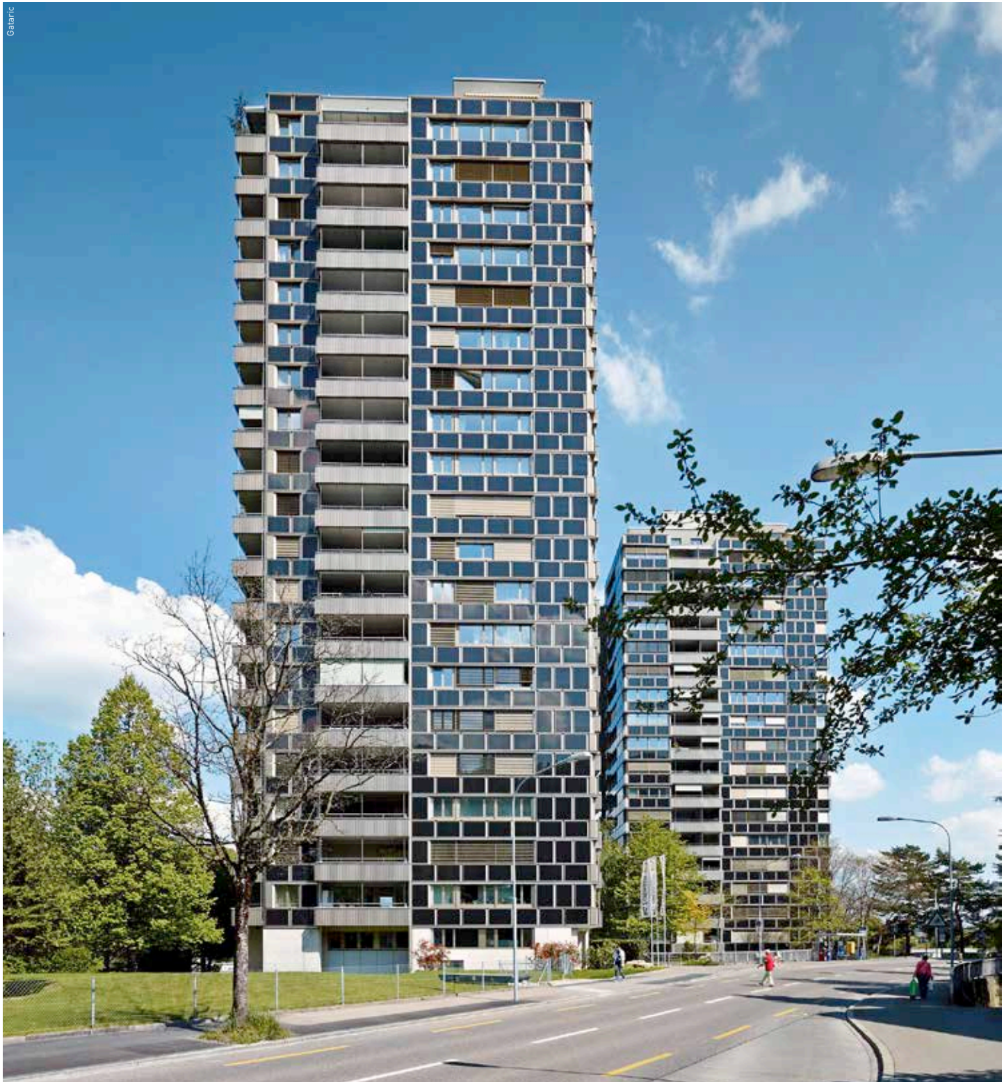
Das mit einer Photovoltaik-Fassade versehene Hochhaus an der Sihlweidstrasse in Zürich wurde vom Forschungsteam der FHNW unter die Lupe genommen.
