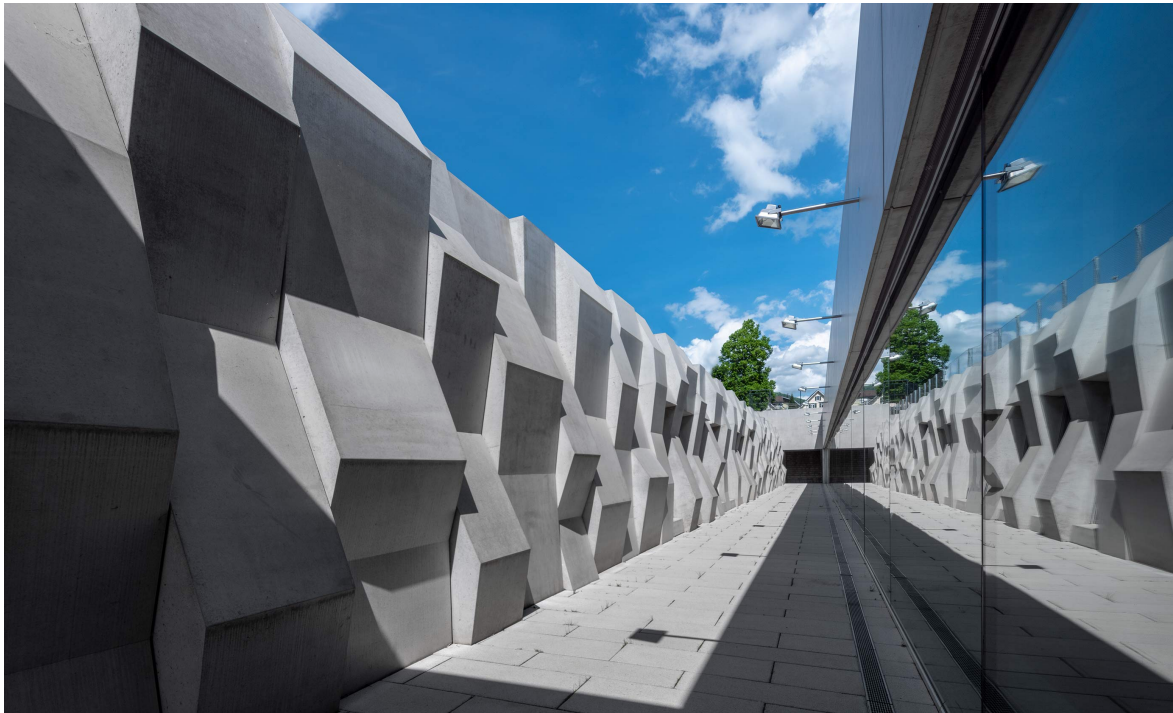
Beautiful Entrance #7 - 2018 Kantonsschule, Wettingen CH © lang/baumann
